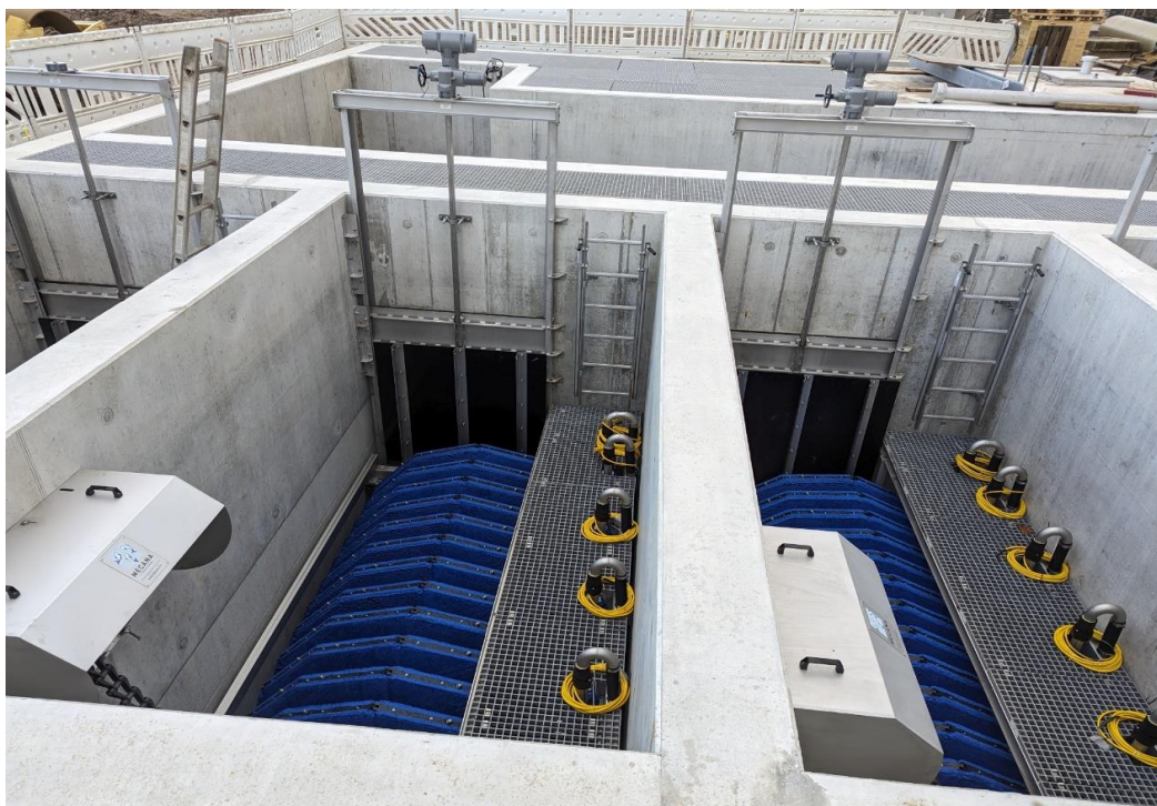
Einbau des Tuchfilters in das neu erstellte Gebäude
