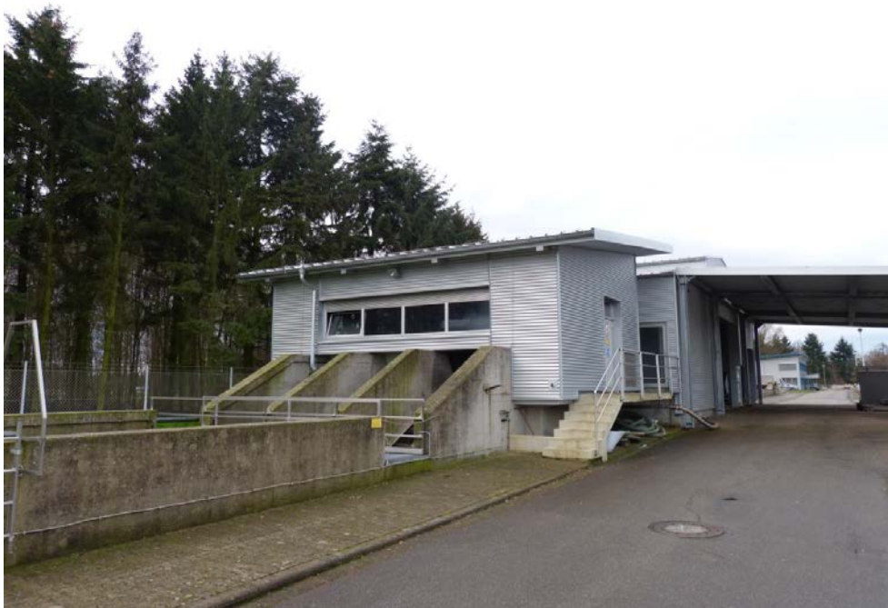
Die sanierte und neu eingehauste Rechenhaushalle
