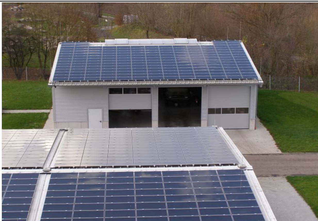
Ein Teil der Photovoltaikanlage, welche auf sechs Gebäude installiert wurde (gesamt 153 kWp).
