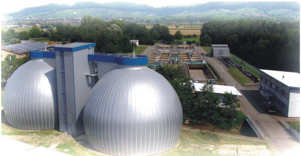
Beide Faultürme nach Fertigstellung der neuen Außenhülle einschließlich dem neu verkleideten Treppenturm.
